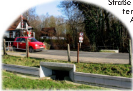
Effektiver Kleintiertunnel mit Leiteinrichtung (3)
