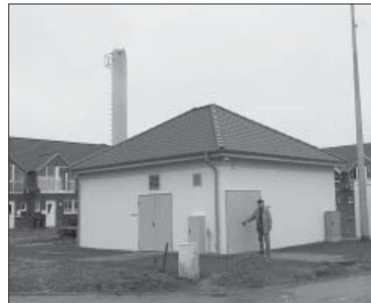
Gasgefeuertes Blockheizkraftwerk in Börnsen
