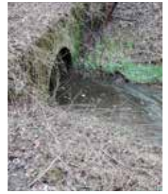
Hier nahm das Übel seinen Lauf: Auslauf des Klärwerks in die Schlei.
