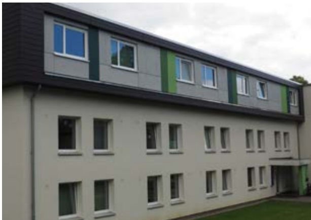
Mehrgeschossiges Bauen bzw. Aufstockung kann bestehende Flächen effektiver ausnutzen. (Foto: Merlin Michaelis, BUND SH)
