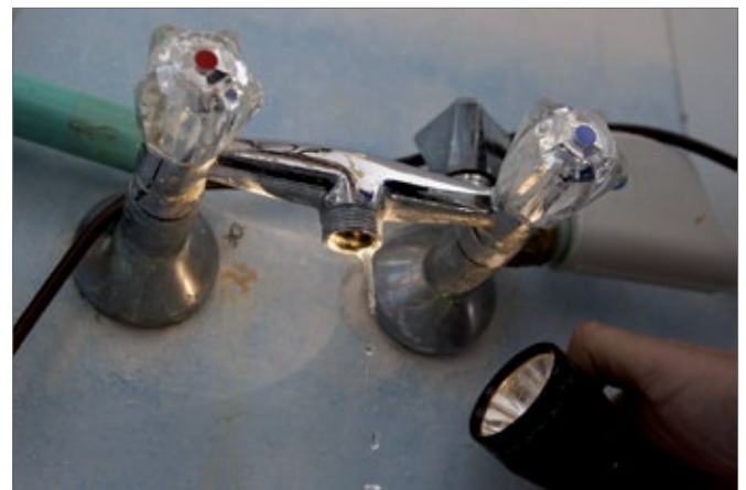
Es tropft! Undichte Armaturen erhöhen nicht nur den Wasserverbrauch. Kann der Ablauf nicht trocknen, droht zudem Verkeimung.
