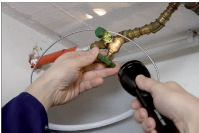
Ist das Absperrventil für die Außenzapfstelle schwergängig? Gut, wenn der Sanitär-Profi vor der nächsten Frostperiode danach schaut.
